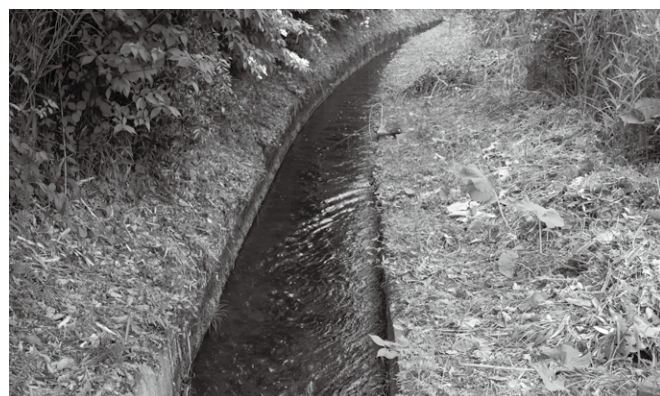
山腹水路（高千穂町三田井地区）。幅 1.15 ~ 1.5 m、傾斜 1/1000
