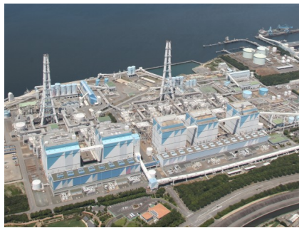
アンモニアの混焼実験が始まった火力発電所 = 愛知県碧南市（JERA提供）
